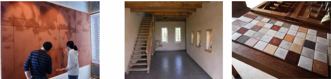
(a) 浙江安吉余村“两山”展览馆生土抹面 (b) 得意楼室内生土抹面 (c) 不同颜色生土抹面展示块
