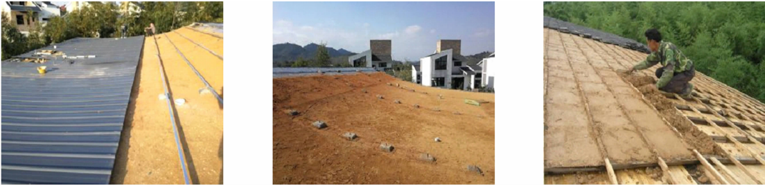
(a) 德意楼屋顶分层 (b) 德意楼屋顶轻质填充土 (c) 文村楼屋顶轻质填充土
