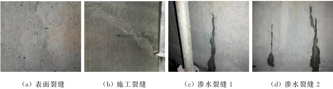
图 6 现场部分裂缝照片(18 m) Fig. 6 Photos of partial crack on site (18 m)
