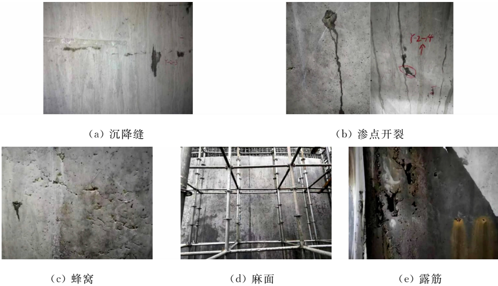
图 1 浇筑内衬墙时出现的质量问题图
