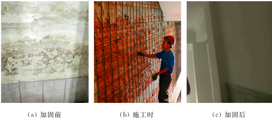
图 2 桥头堡填充墙加固前、后照片对比
