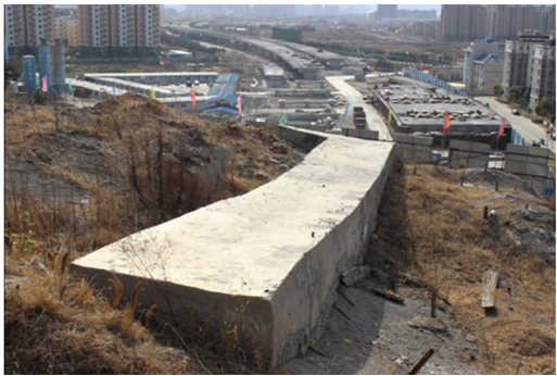
(b) 钢管桩+冠梁加固坡体
