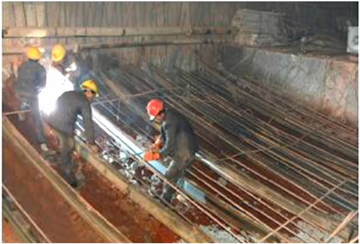
(b) 仰拱浇筑控制洞身变形
