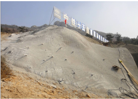
(a) 小导管注浆加固坡体
