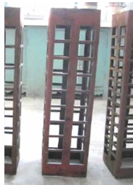
图 2 加工好的钢板笼 Fig. 2 Prefabricated steel cage
