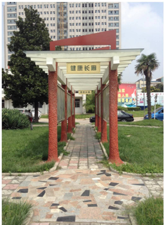
图 2 钢筋混凝土框架结构廊架
