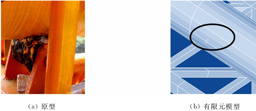
图 3 管道与桥面滚轴支座 Fig. 3 Connection pipeline and deck slab
