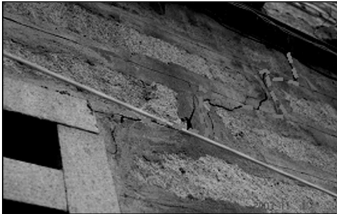
(a) 石墙阶梯型裂缝
