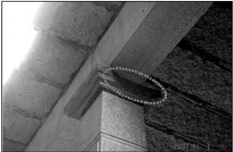
(b) 柱帽局部受压崩裂
