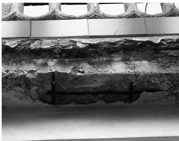
图 2 混凝土梁钢筋锈胀严重
