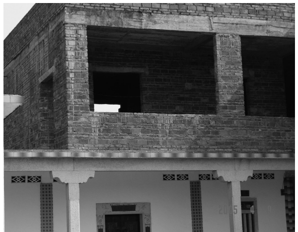
图 1 石梁上加建砖墙
