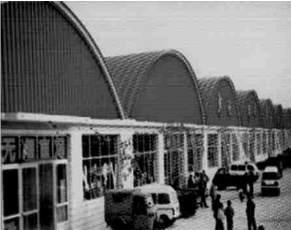
图 1 拱形波纹钢屋盖结构
